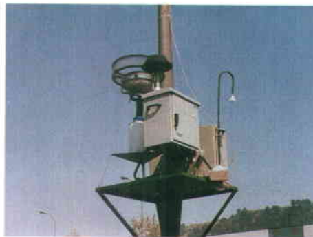
Indicador de contaminación atmosférica.
